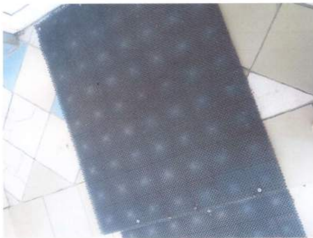
Рисунок 9. Входная площадка (перед дверью)
